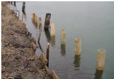
汽水域汀線沿いにキトサン銅錯体処理杭を打ち込む
