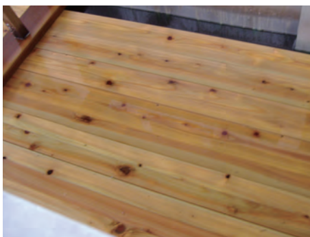
キトサン銅錯体注入処理材 (モスグリーン色に仕上がる)
