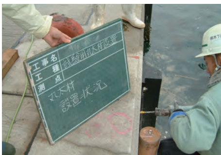
漁港の防舷材として岸壁に沿ってキトサン銅錯体処理材を打ち込む
