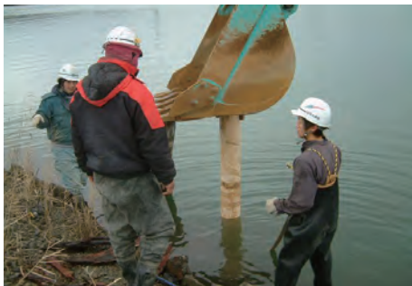
汽水域汀線沿いにキトサン銅錯体処理杭を打ち込む
