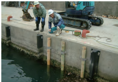
漁港の防舷材として岸壁に沿ってキトサン銅錯体処理材を打ち込む
