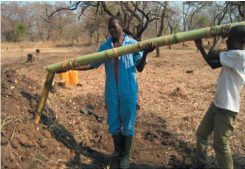
タケの節を抜いて、排煙口に接続し、煙突をつくる
