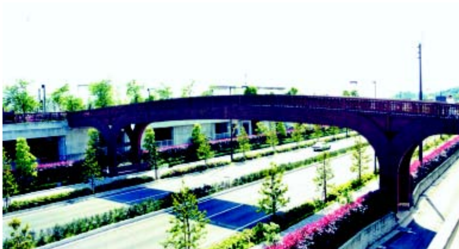
集成材建造物⑥ 南江戸公園連絡歩道橋(日本集成材工業協同組合 齋藤木材工業㈱提供)
