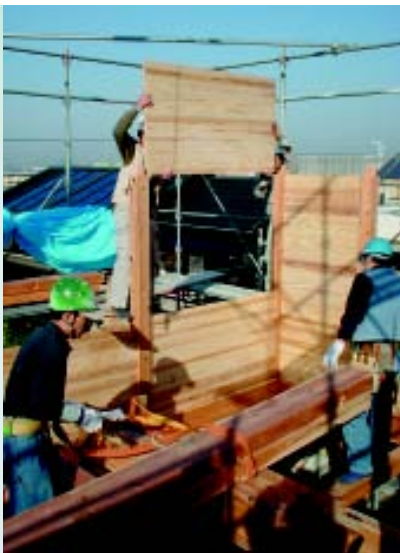
J パネル落とし込み施工作業(上) J パネル(挽き板三層クロス構造) (左) (協同組合レングス提供)
